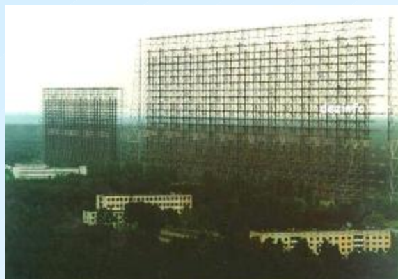
Передающая и приемная ФАР РЛС 5Н32 (г. Припять)
