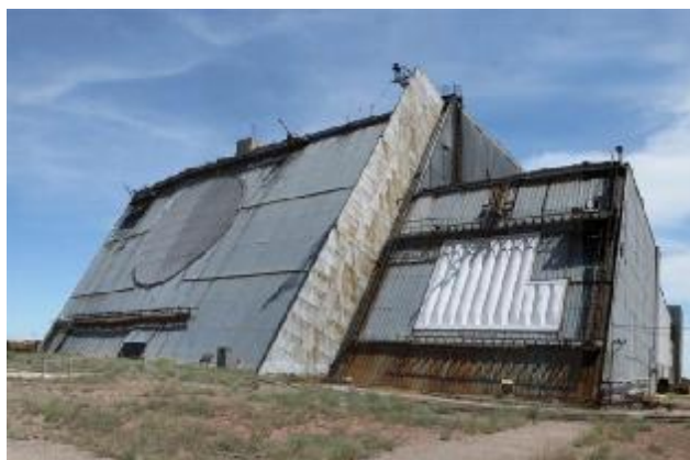
РЛС «Дон- 2НП» на Балхашском полигоне
