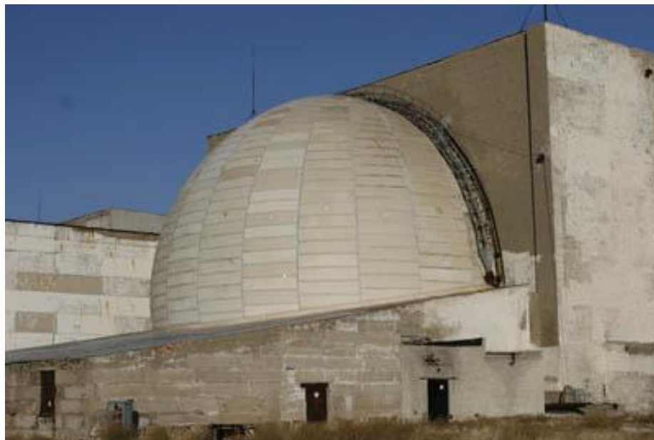
Приемная позиция РЛС «Неман» на Балхашском полигоне
