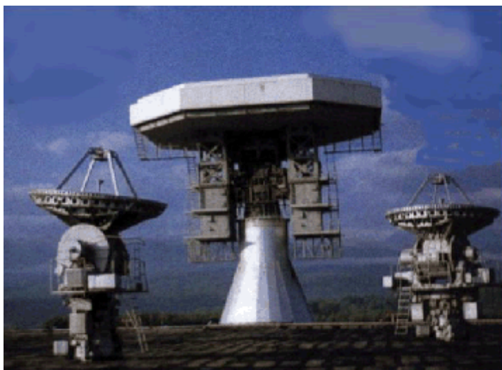
РЛС комплекса «Крона» у станции Зеленчукская. В центре – РЛС дециметрового диапазона с ФАР
