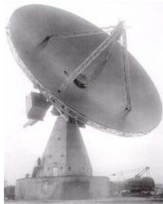
Рис. 7. Трехзеркальная антенна для дальней космической связи ТНА-400 (г. Симферополь) [9].
