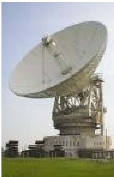
Рис. 9. Радиотелескоп РТ-70 с двухзеркальной антенной с профилированными зеркалами (г. Уссурийск) [39].
