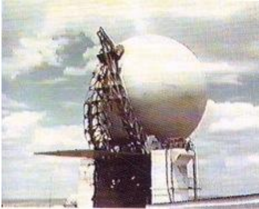
Рис. 5. Радиолокатор для обнаружения и сопровождения баллистических ракет с антенной Кассегрена (п. Сары-Шаган) [4].
