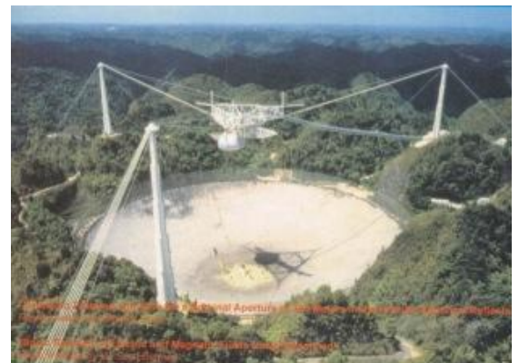
Рис. 14. Трехзеркальная антенна радиотелескопа с неподвижным сферическим зеркалом и двухзеркальной облучающей системой (Аресибо) [63].
