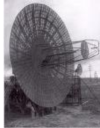
Рис.6. Антенна Кассегрена для радиолокатора обнаружения и сопровождения баллистических ракет (г. Аральск) [5].
