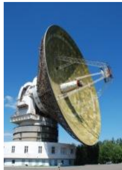
Рис. 10 Радиотелескоп с двухзеркальной антенной с профилированными зеркалами ТНА-1500 (п. Медвежьи Озера) [9].
